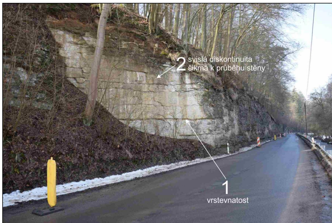
Foto 1 Výrazná stěna na jihovýchodním okraji nestabilního území kopírující systém diskontinuit 2. Dobře patrná je lavicovitá vrstevnatost označená jako systém diskontinuit 1. Dále směrem k severozápadu pokračuje nestabilní stěna odřezu silnice II/277 paralelní s jejím průběhem. Na fotografii je dobře patrné, že před patou stěny zůstává jen nepatrný nebo dokonce vůbec žádný prostor pro akumulaci úlomků skalních řícení.
