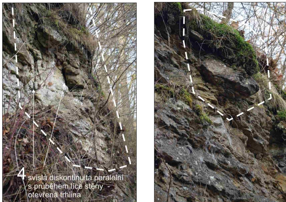
Foto 7 Vlevo – ukázka nestabilní části líce stěny vymezené systémem diskontinuit 4 (diskontinuity paralelní s průběhem líce stěny), vpravo – ukázka převislých částí v horní části stěny a volných bloků hrozících pádem.
