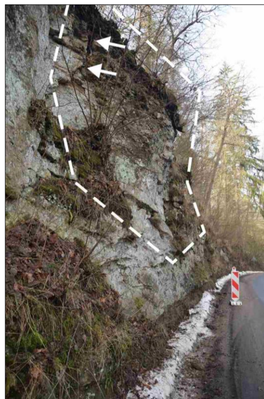
Foto 4 Nestabilní blok ve stěně (dtto foto 3) zvýrazněný bílým polygonem. Vlevo – pohled od severozápadu, vpravo – pohled od jihovýchodu. Bílými šipkami jsou zvýrazněny otevřené trhliny.
